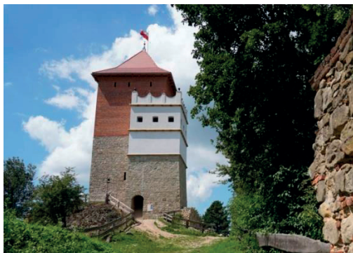
Wieża zamku w Melsztynie wraz z przyporą – widok po całkowitej odbudowie w latach 2018-2025 (zdjęcie wykonane w 2025 r.)
