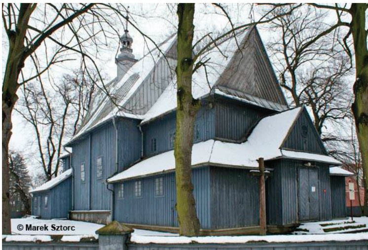
Dzwonnica kościelna. Z XVIII—XIX wieku. Drewniana, konstrukcji słupowej. Kwadratowa, o ścianach pochyłych, z nadwieszoną izbicą, nakryta dachem namiotowym.
