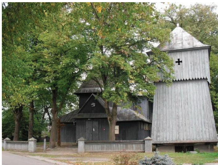
Dzwonnica kościelna. Z XVIII—XIX wieku. Drewniana, konstrukcji słupowej. Kwadratowa, o ścianach pochyłych, z nadwieszoną izbicą, nakryta dachem namiotowym.
